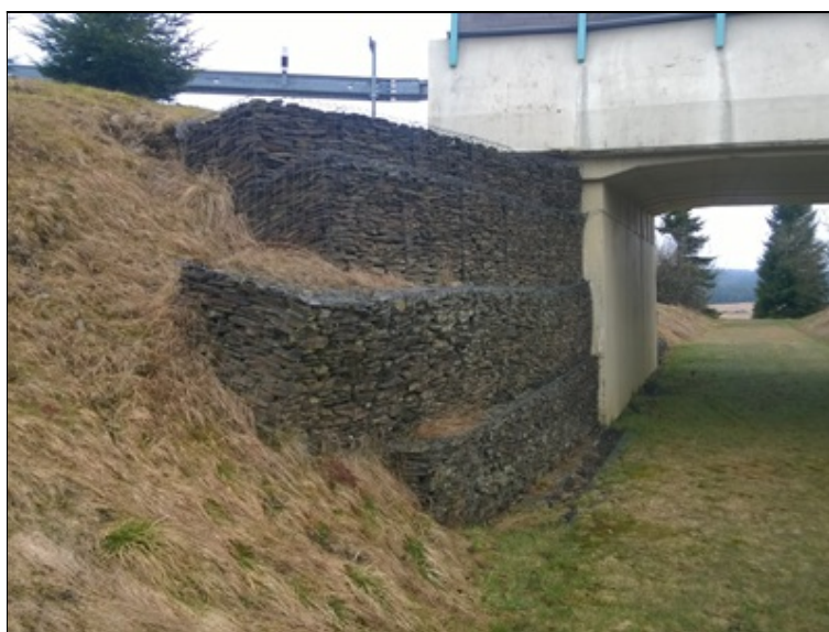
Deformace gabionových křídel
