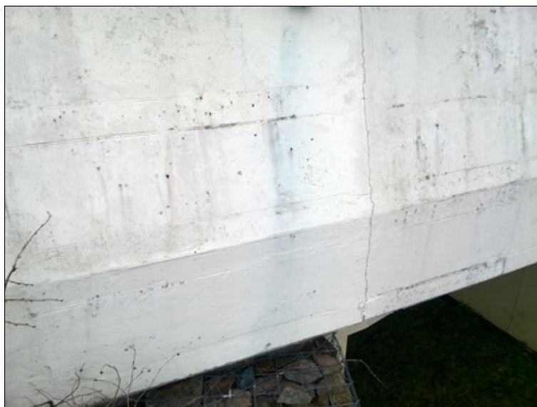
Trhliny ve svodidlech
