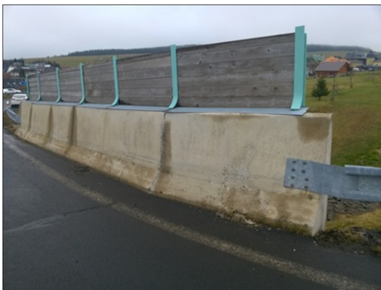
Uspořádání na okrajích mostu
